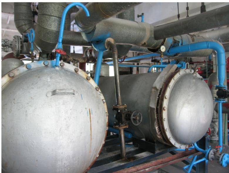
Рисунок 1.11 – Пароводяные подогреватели сетевой воды МВН 1437-0,5
